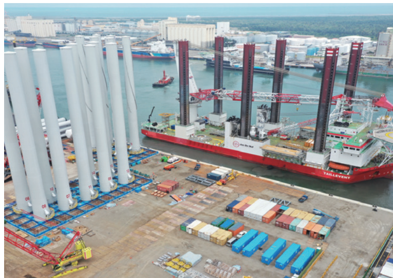
位於臺中港的風機預組裝基地。
