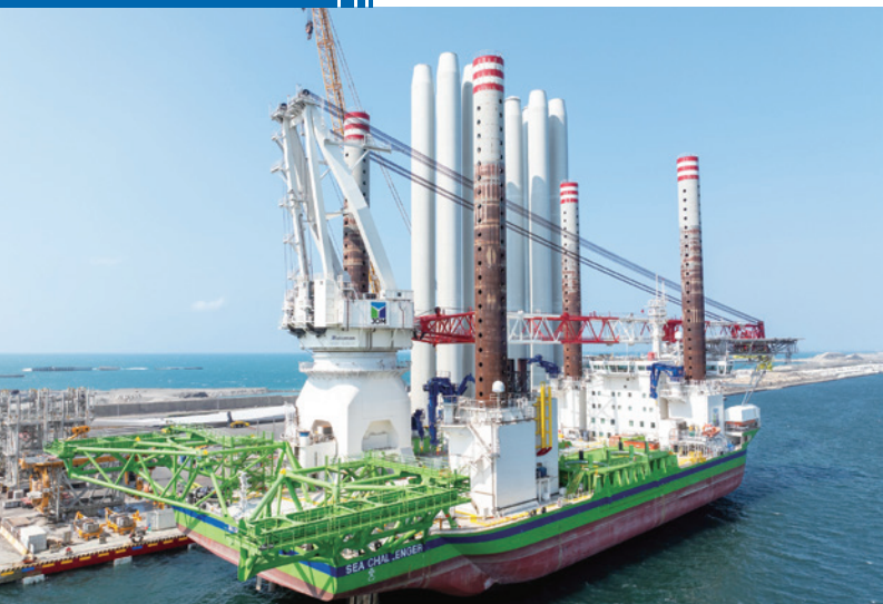
離岸風電工作船作業中。
